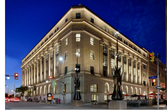
Eksempel på myk og diffus belysning som markerer byggets struktur.
